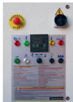
Electromechanical control panel. Cuadro de control electromecánico.
